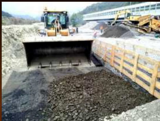
Водозаборное сооружение, г. Адлер
