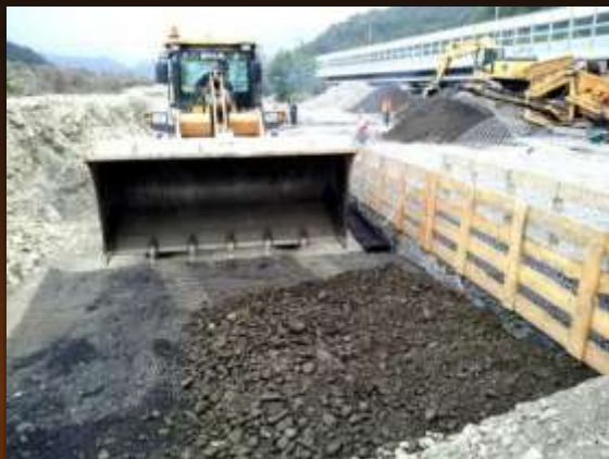
Водозаборное сооружение, г. Адлер
